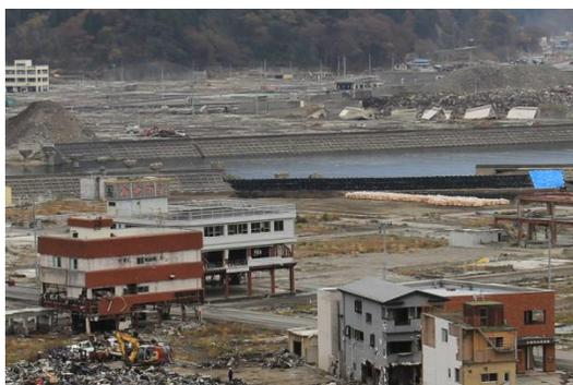
図7 損壊した堤防(黒い部分)
