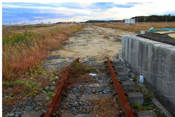
図 23 流失した常磐線の線路
