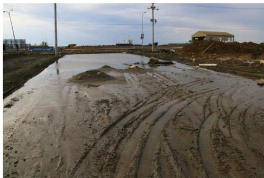
図 18 地盤沈下した道路
